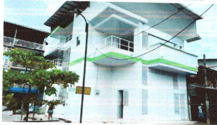
Ilustración 25 Mantenimiento infraestructura casa de la cultura
